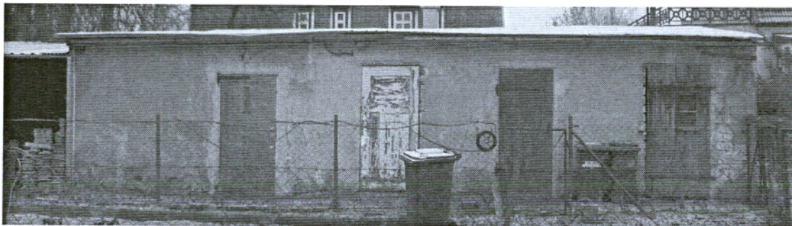
Ilustracja 2: Widok elewacji północnej Budynek A
