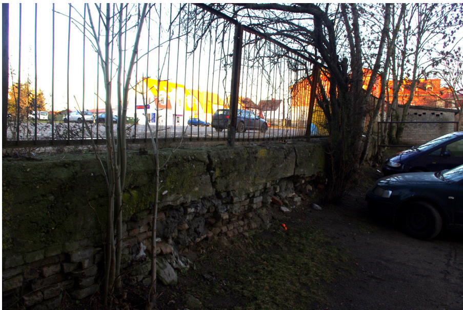
Fot. 1 Murek i przęsta ogrodzeniowe - widok od strony południowo-zachodniej.
