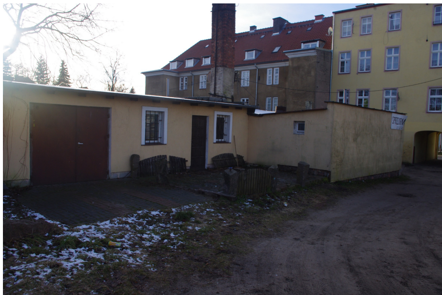
Fot. 5 Budynek dawnej piekarni - widok od strony północno-wschodniej, w tle budynki mieszkalne przy ulicy Wojska Polskiego 1 i 3.
