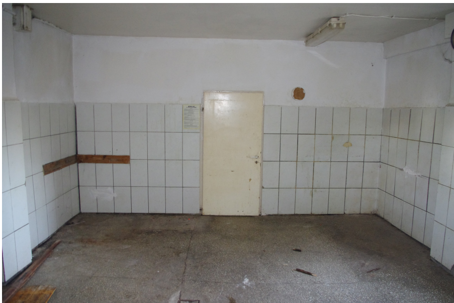
Fot. 11 Budynek dawnej piekarni - wnętrze budynku.
