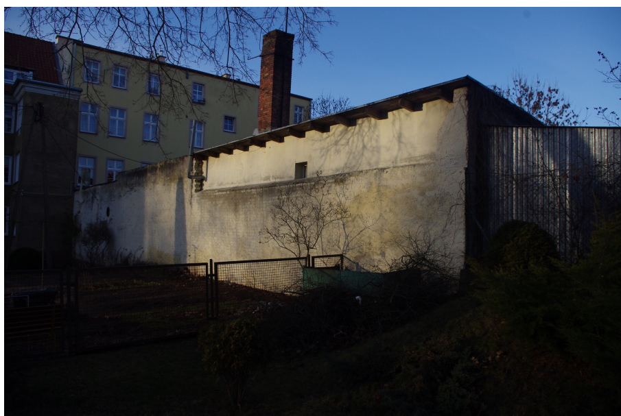
Fot. 10 Budynek dawnej piekarni - widok od strony południowo-wschodniej.
