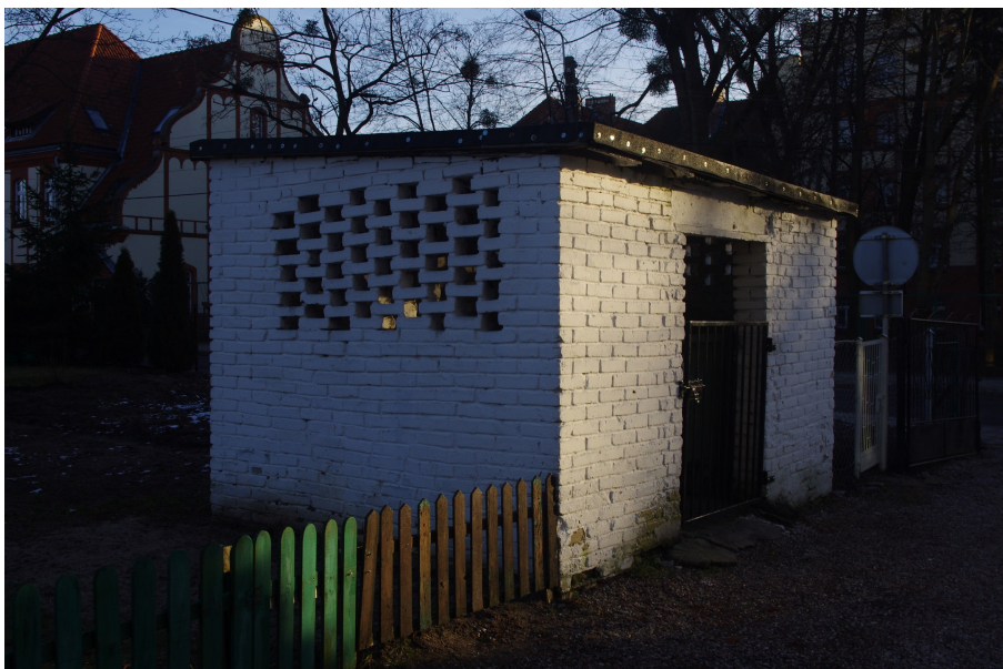
Fot. 13 Śmietnik murowany nr 2- widok od strony północno-zachodniej.
