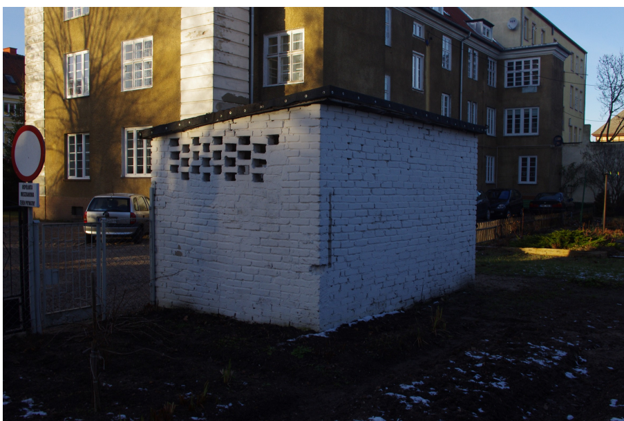
Fot. 14 Śmietnik murowany nr 2- widok od strony południowo-wschodniej.
