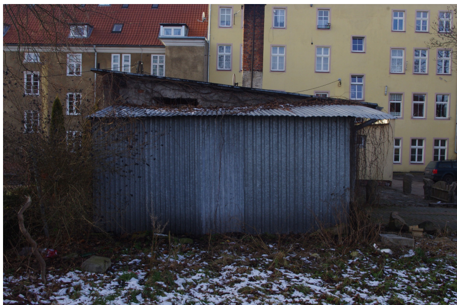
Fot. 6 Budynek dawnej piekarni - widok od strony wschodniej.
