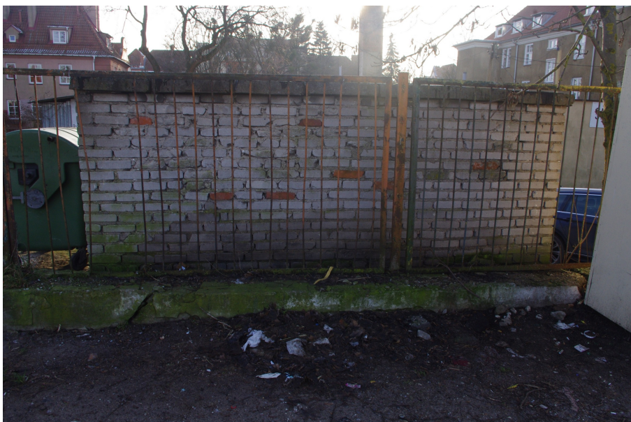
Fot. 4 Śmietnik murowany nr 1 - widok od strony północnej.
