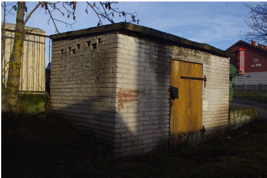
Fot. 3 Śmietnik murowany nr 1 - widok od strony południowo-zachodniej.
