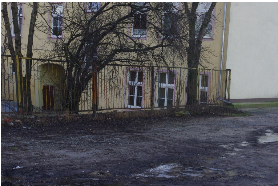
Fot. 2 Murek i przęsta ogrodzeniowe - widok od strony północno-wschodniej.
