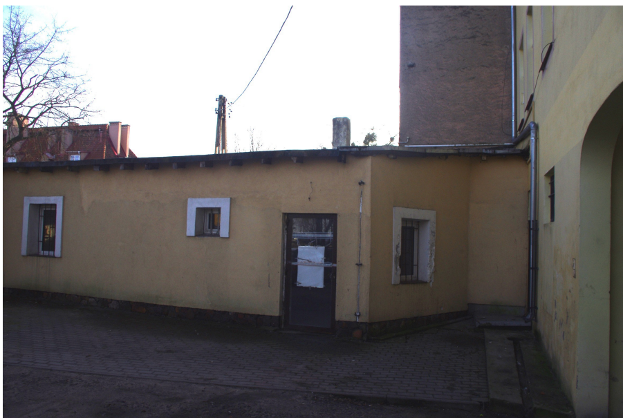
Fot. 7 Budynek dawnej piekarni - widok od strony północnej, część zachodnią, na styku z budynkiem mieszkalnym przy ulicy Wojska Polskiego 1, w tle budynek mieszkalny przy ulicy Wojska Polskiego 3.
