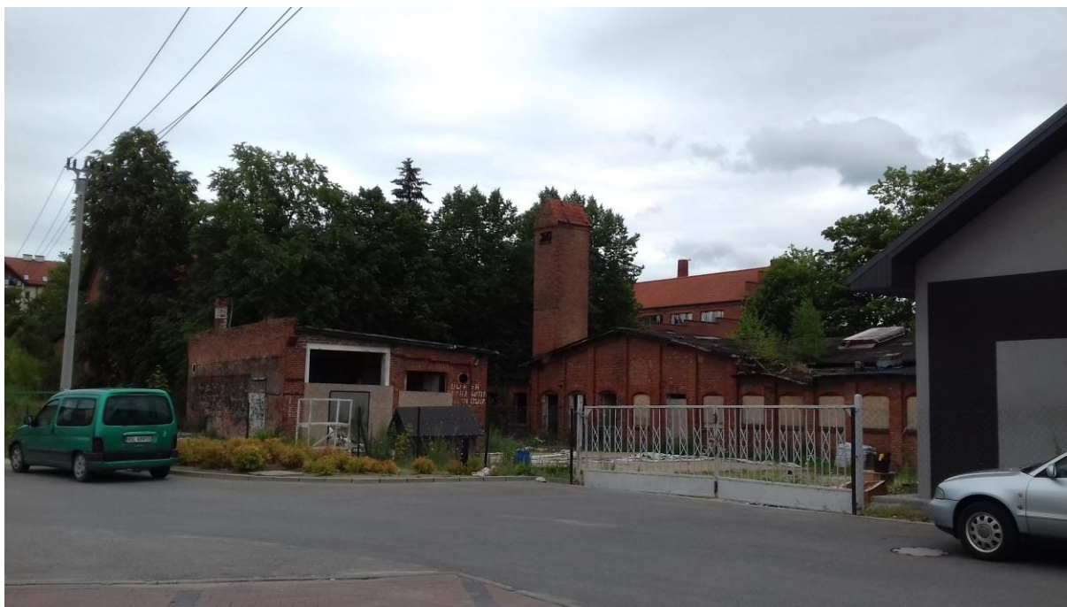
Fotografia 9. Budynki starej gazowni wpisane do rejestru zabytków
