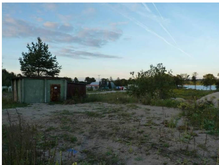
Zdjęcie. Teren objęty projektem zmiany planu określony na Załączniku nr 1b – stacja transformatorowa średniego napięcia zlokalizowana części wschodniej terenu, w oddali jezioro Juno graniczące z terenem opracowania.
