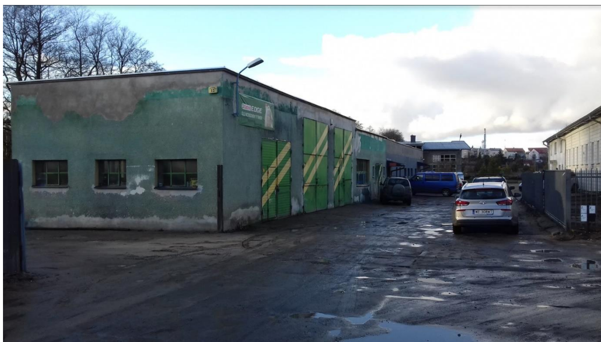
Fotografia 2. Zabudowa usługowa z zakresu motoryzacji, widoczne nieutwardzone drogi wewnętrzne i miejsca postojowe
