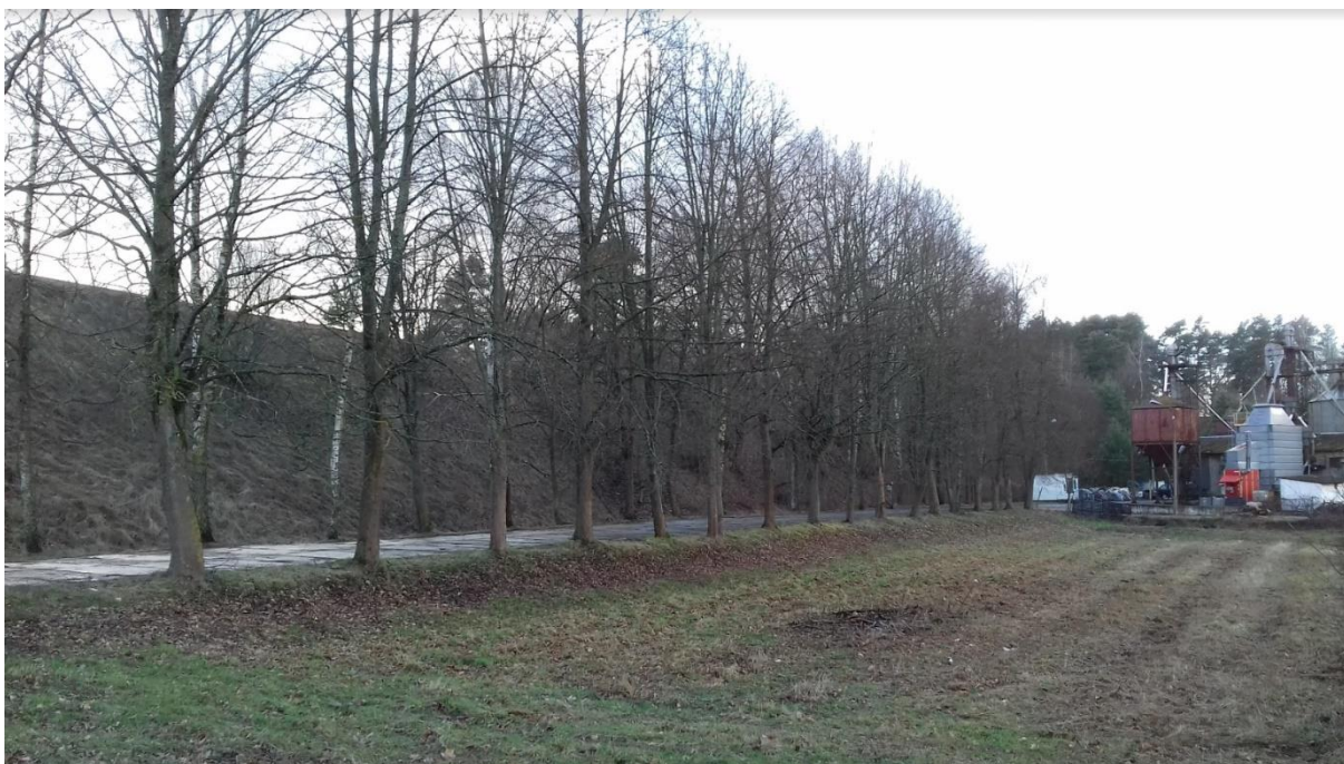
Fotografia 10. Droga ze szpalerami drzew prowadząca do zakładu suszenia słomy. Widoczny nasyp kolejowy
