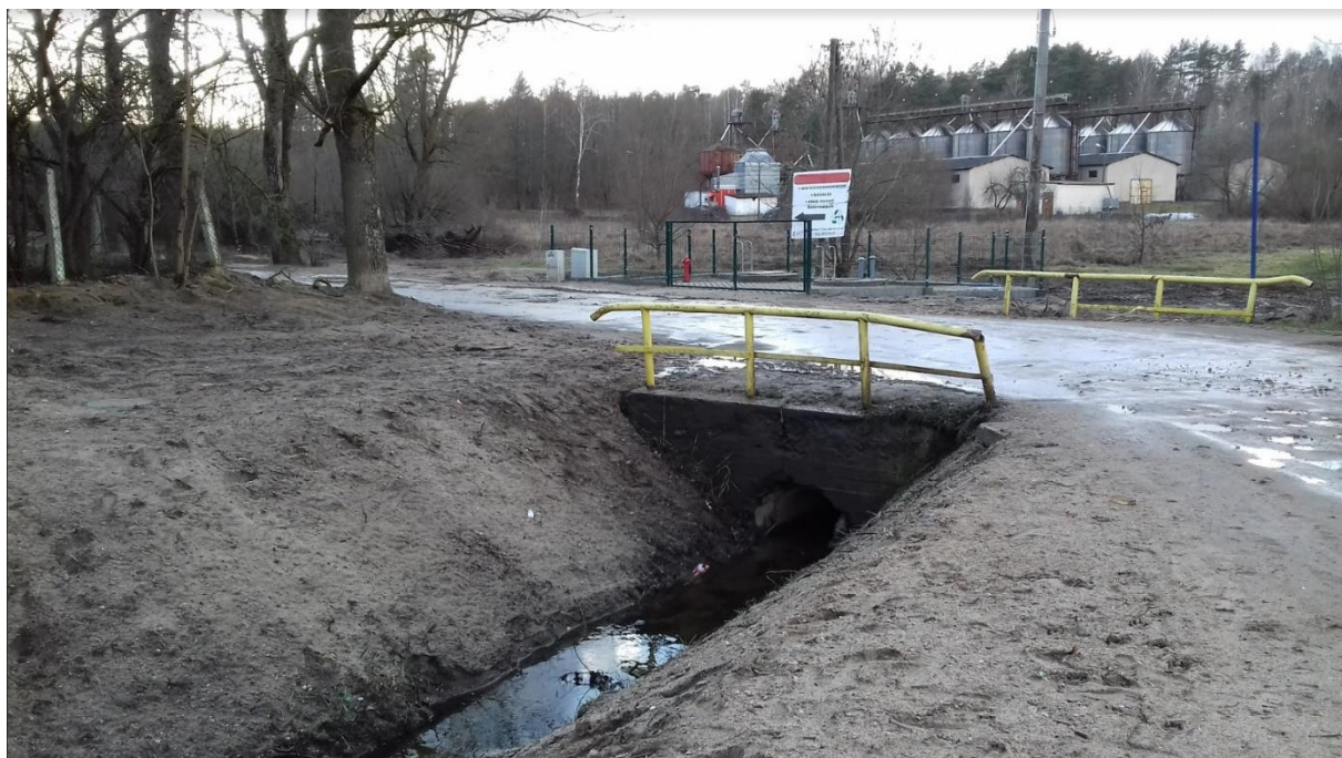
Fotografia 8. Przepust nad Nikutowską Strugą w zachodniej części obszaru
